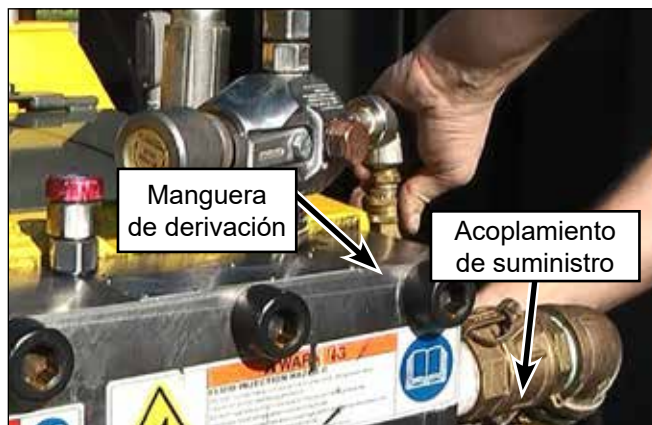
Figura 62: Extracción de la tubería.
