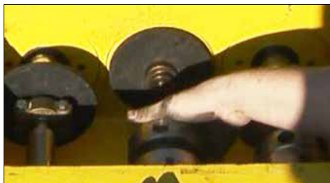
Figura 59: Instalación de la tuerca.
