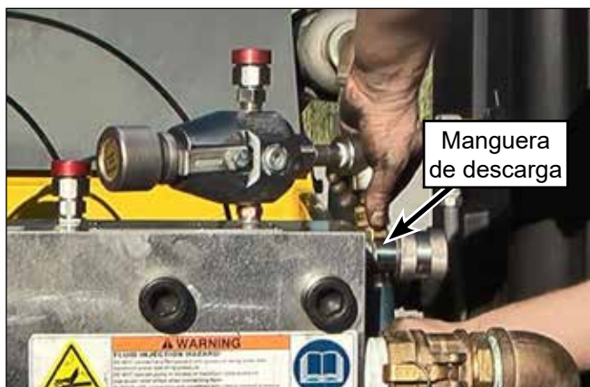
Figura 93: Extracción de la manguera de descarga.
