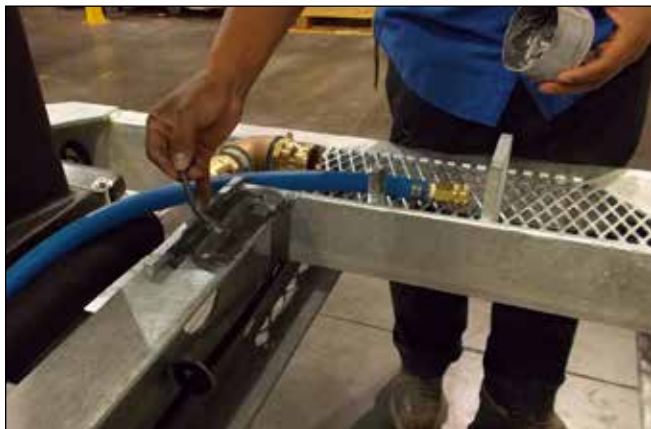
Figura 128: Aplicación de antiadherente a los canales de la bomba.
