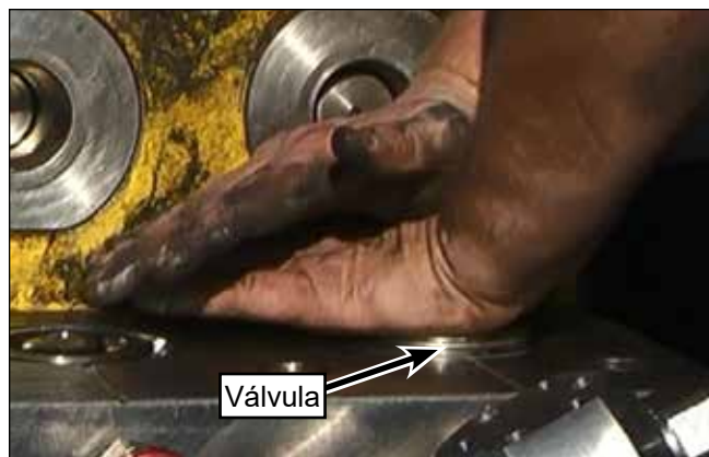
Figura 68: Instalación de las válvulas.
