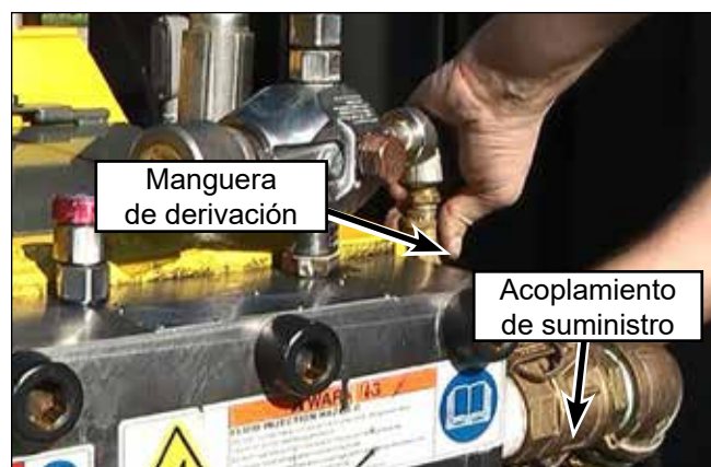
Figura 21: Extracción de la tubería.
