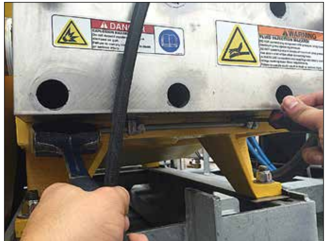
Figura 35: Instalación de la barra de bisagra.
